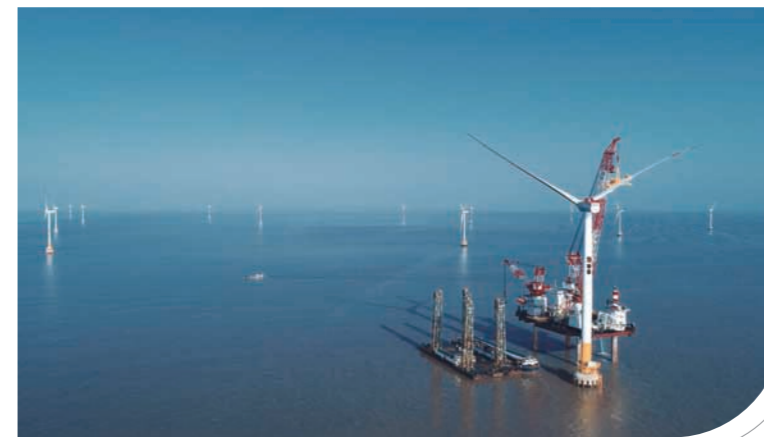
临港海上风电一期6MW样机项目叶片吊装
