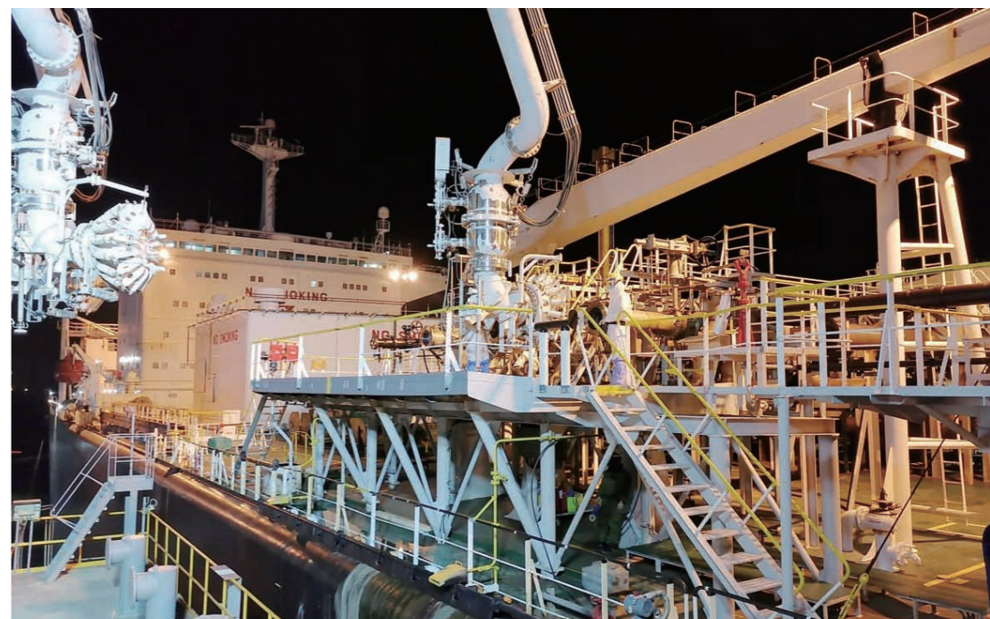
燃气集团旗下天然气管网公司员工在五号沟LNG站开展接船工作
