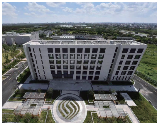
上海移动临港数据中心建设
