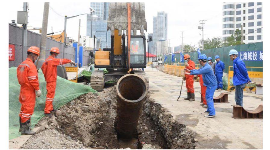
老旧管网改造
