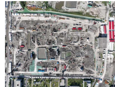
泰和污水处理厂扩建工程
