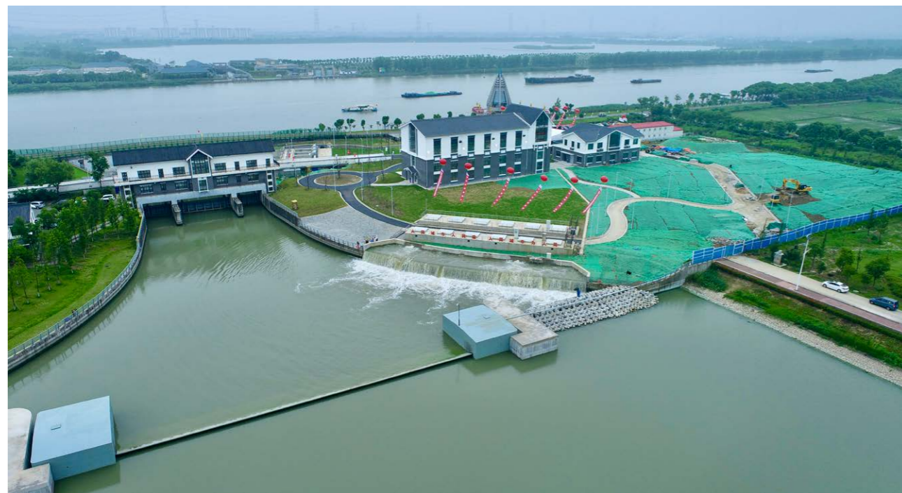
金泽水库新增取水泵站工程
