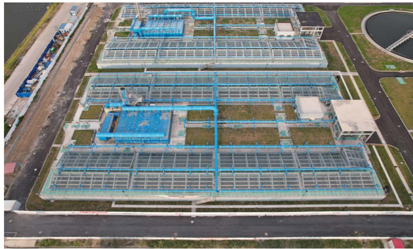
临港污水厂二期
