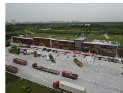
G40 公路长兴岛西侧服务区
