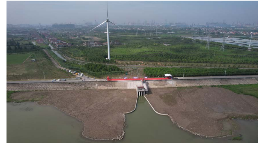
青草沙水库南侧换排水口工程
