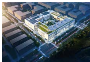
公司在雄安开展的国内首个负碳建筑咨询项目
