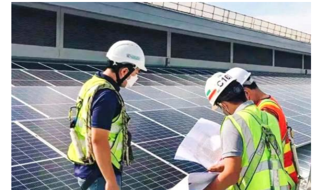
海外总承包项目新加坡 LTA C9355 屋顶光伏项目圆满完成
