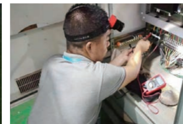
河南新乡，威派格售后员工接到客户维修电话后，随即前往现场，但因路面水深汽车无法通行，便及时改换骑车赶往现场检修，经过2小时到达现场，最终2小时内让用户恢复供水。
