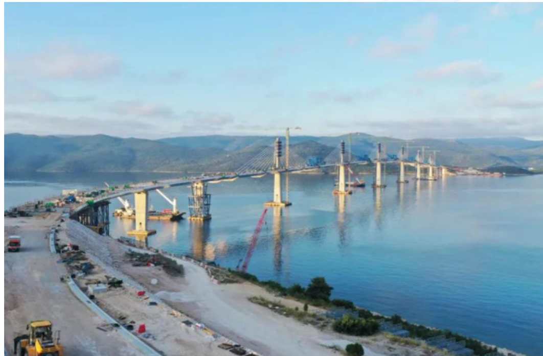
罗地亚佩列沙茨大桥。
