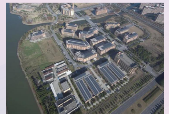
上海电机学院光伏项目。
