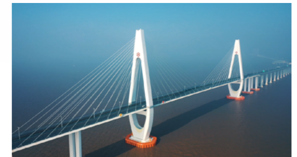
振华重工参建的宁波舟山港主通道项目。
