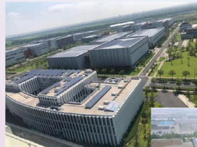
上海体育职业学院光伏项目。
