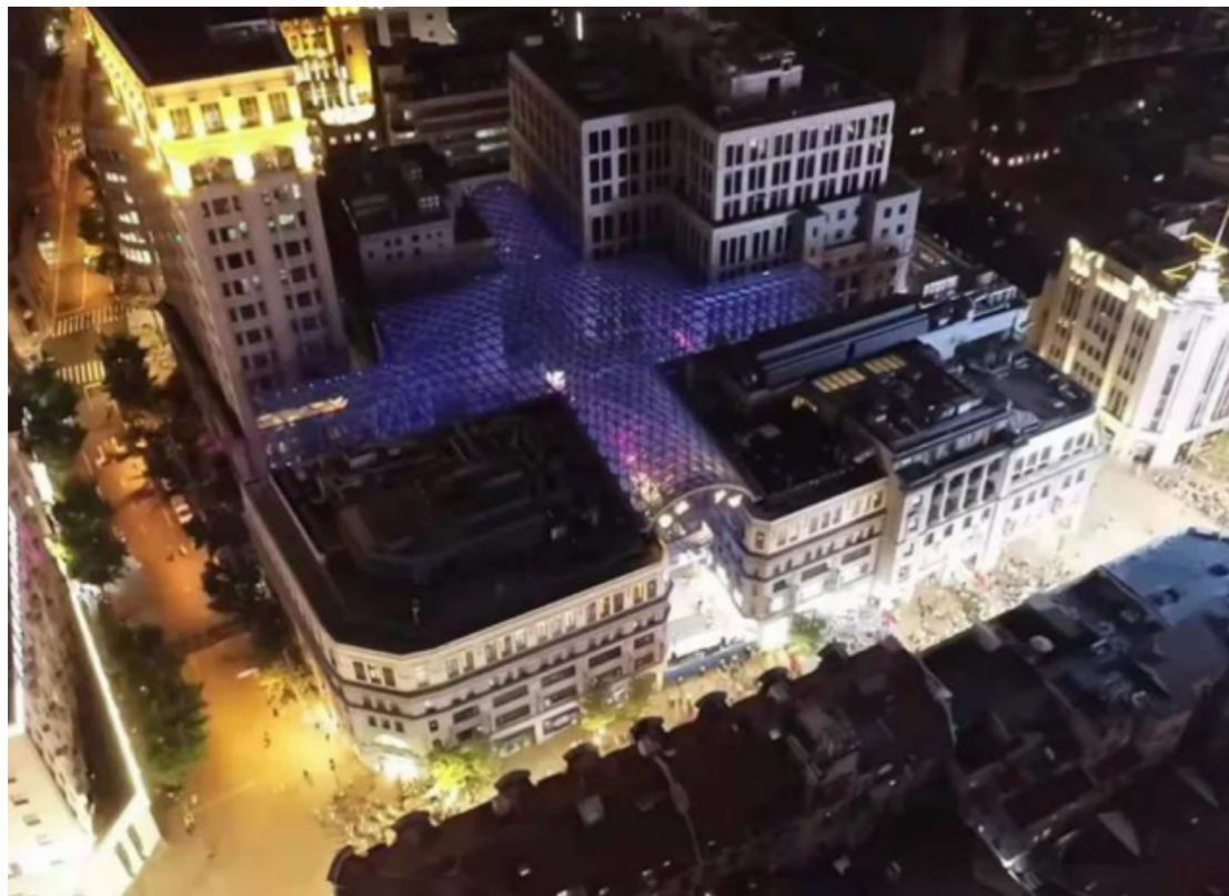
振华重工建造的巨幅十字穹顶。
