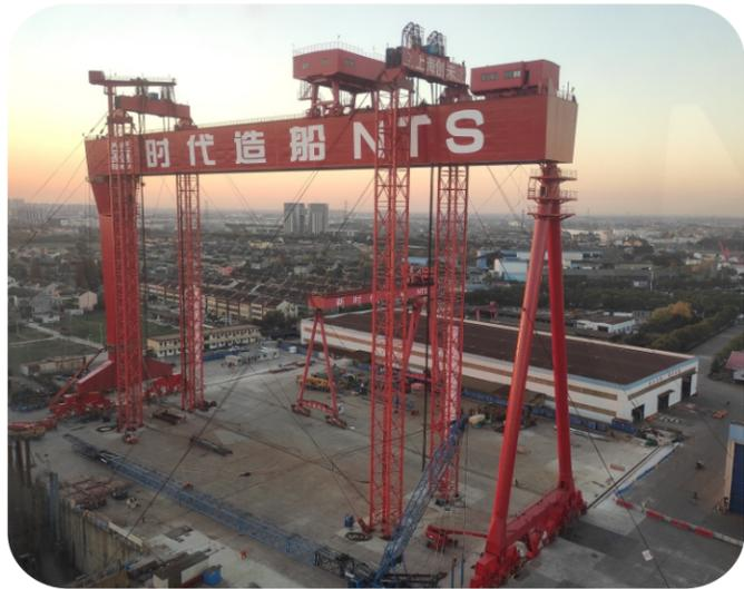
中船九院设备院负责设计建造的江苏新时代造船有限公司800吨门式起重机提升圆满完成，此次提升共历时12天，采用双塔架液压同步提升方法。该起重机跨度126米，主梁底部标高65米，可实现上下小车抬吊重量800吨，空中翻身最大重量700吨。
