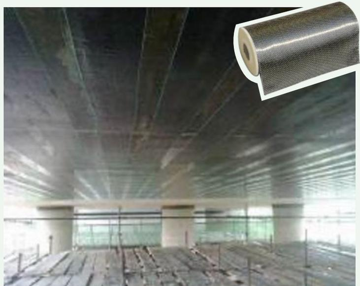
浦东建设使用碳纤维布加固桥梁
