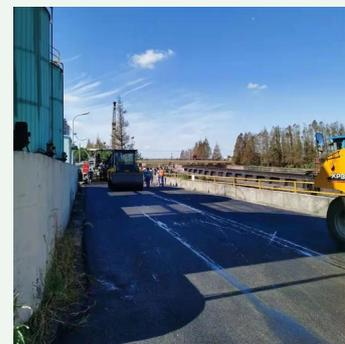
热拌超薄磨耗层技术研究试验段图片
