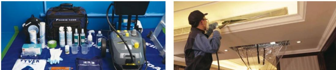
大金使用专用遮蔽膜对用户家里的地面、墙壁及家具做全面防护；使用漏斗形装置，使清洗污水集中到收集容器中；使用大金空调专用清洗剂和空调专用消毒水，搭配高温高速蒸汽清洗，安心杀菌更彻底；最后使用防霉抗菌的镀膜剂喷洒在积水盘等表面，形成镀膜，达到长久抑菌的效果
