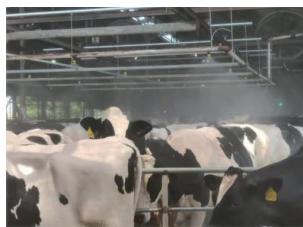
金山牧场安装智能喷淋降温
