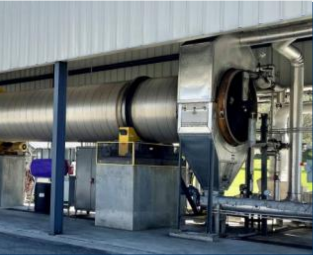
在布莱克斯堡的热干燥 (木兰纺织和艾伦化工厂，美国) 废水生物固体，通常指 作为污泥，是从我们的废水中产生的废物 处理过程和需要适当的 处理我们的工程师设计了一种方法来实现 在帮助下减少生物固体的数量 热干燥。在 2021 年，我们建造了我们的第一个 生物固体干燥器。在 2022 年，我们看到了全年运营的好处，证明了这个过程每年可以有效地 减少近 800 万英镑的浪费。到 2023 年，我们将 看到钻井作业的好处 测量到的废物减少了 1100 万英镑。
