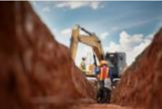
建筑结构和基础设施
