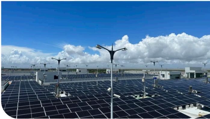
浦东机场 P4 屋顶光伏项目建设光伏区域总面积为 **12062** 平方米，竣工总容量 **1.5903** 兆瓦，项目采用“自发自用、余电上网”模式。项目全容量投产后，预计年发电量 **173** 万度，日均发电量约 **4800** 度，每年减少二氧化碳排放约 **727** 吨，相当于每年为社会节约了 **622** 吨标准燃煤。
