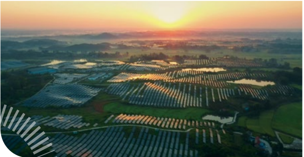
申能金寨太科光伏发电项目
