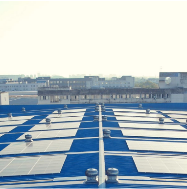
江苏宏源电气有限责任公司建设分布式光伏电站
