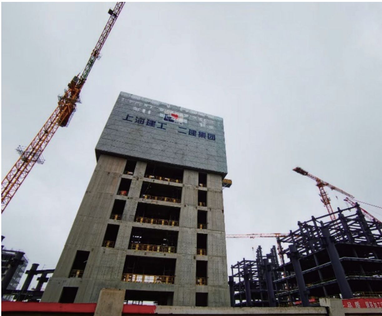
项目施工现场
