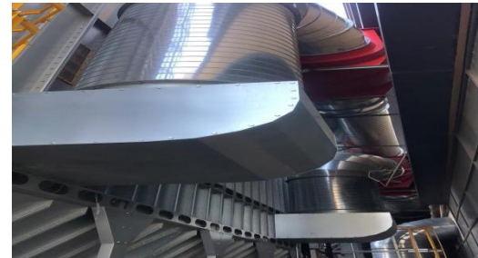
新改造升级的除尘收集管道
