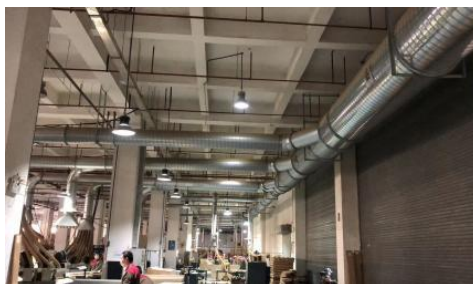
新改造升级的除尘收集管道
