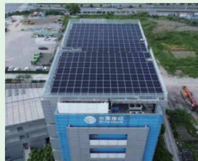
松江移动核心机房光伏楼顶
