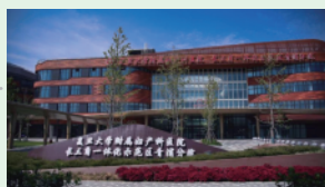
上海 青浦“红房子医院” 智慧医疗微模块机房
