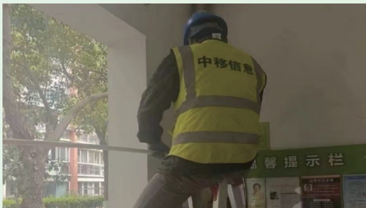
施工人员对监控系统开展升级改造
