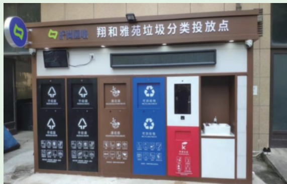
南翔智能垃圾房实景
