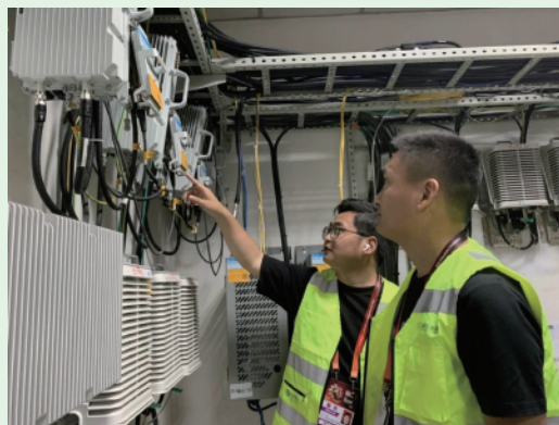
开展地下车库网络覆盖查勘
