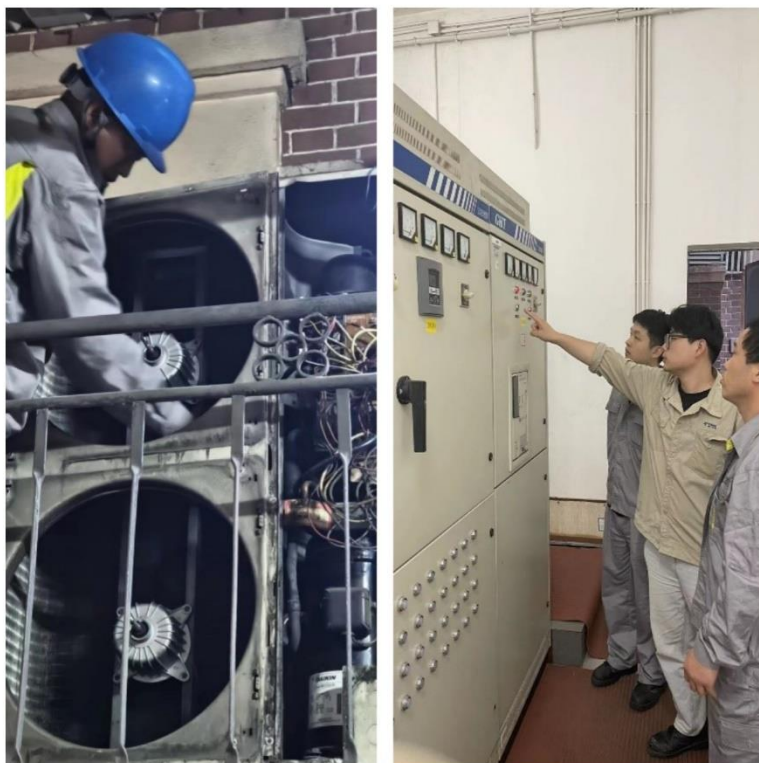
（左图，强化空调外机检修，有效提升制冷效果。右图，专业维护，电容检测，确保安全和低耗运行）
