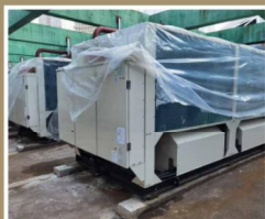
东方明珠电视塔更换变压器
