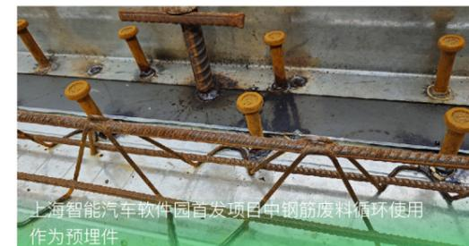
上海智能汽车软件园首发项目中钢筋废料循环使用作为预埋件。
