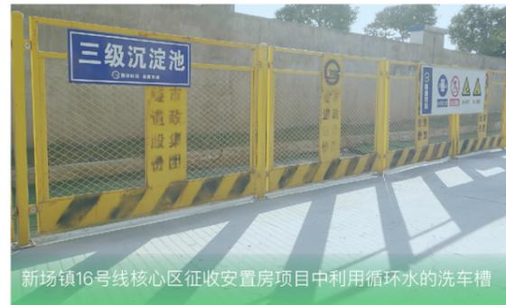
新场镇16号线核心区征收安置房项目中利用循环水的洗车槽
