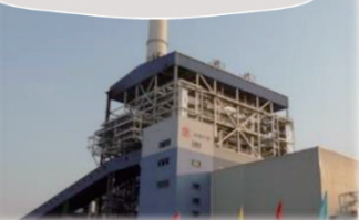
300~660MW等级 超临界“W”火焰锅炉
