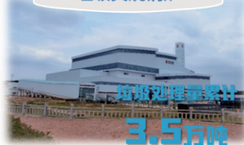
垃圾焚烧锅炉
