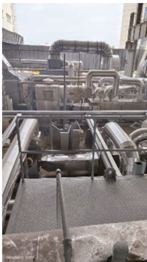
16米喷漆室VOC治理沸石转筒改造项目
