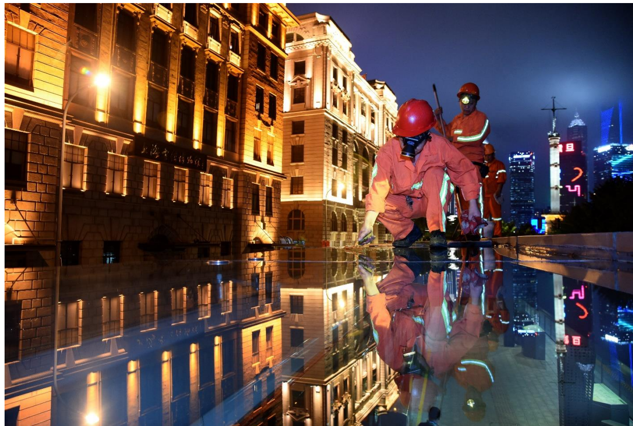
中运量沿途站点顶棚清洗
