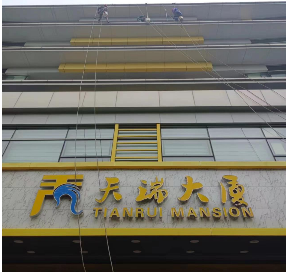
天祥天瑞大厦商务楼外墙清洗
