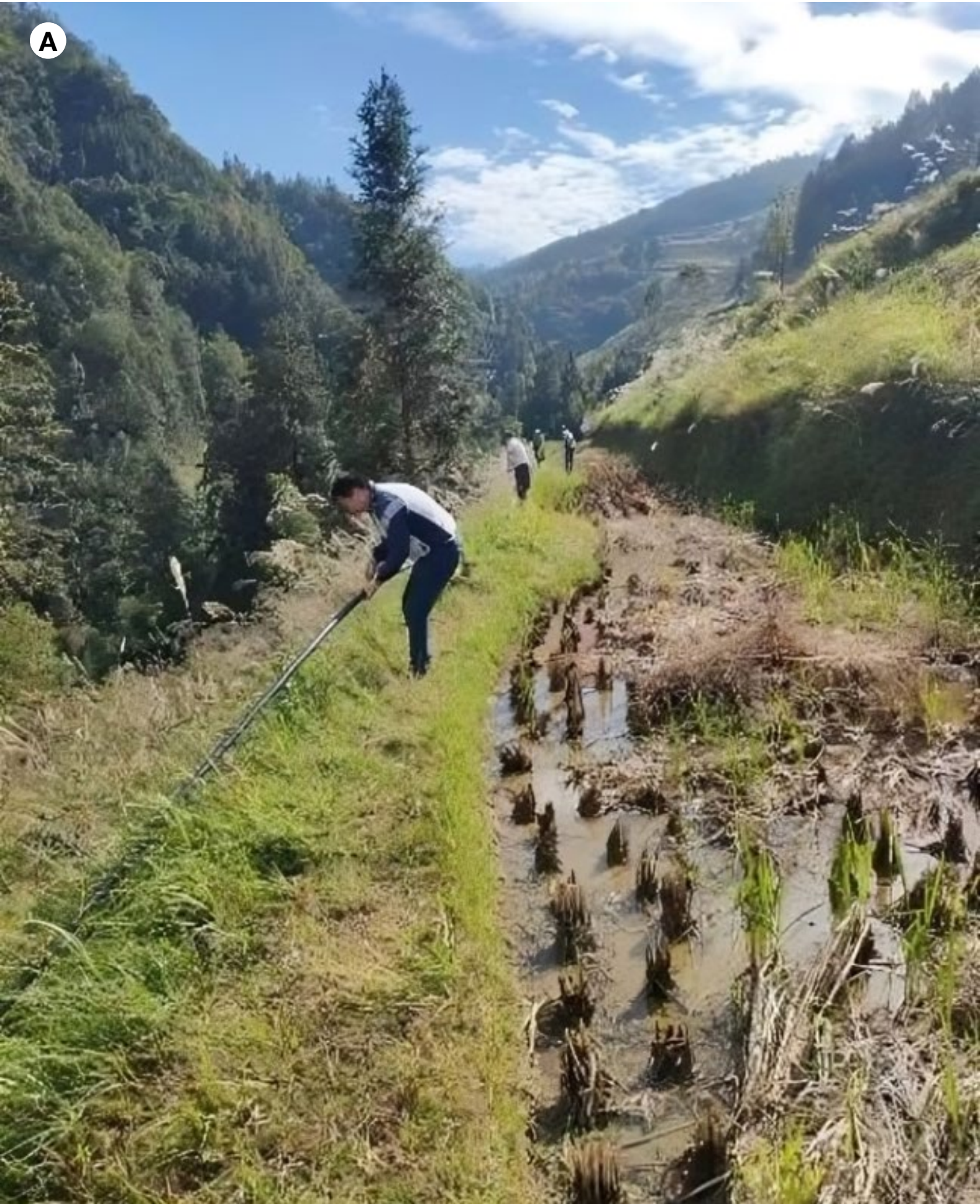
在广西壮族自治区更换管道和排水沟，以支持清洁水进入。
