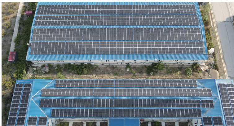
土耳其胡努特普风光混合电站项目首批屋顶光伏组件顺利并网，充分利用闲置土地和已构筑屋顶，是土耳其首批批准的煤电 + 新能源“多能源混合型发电站”。
