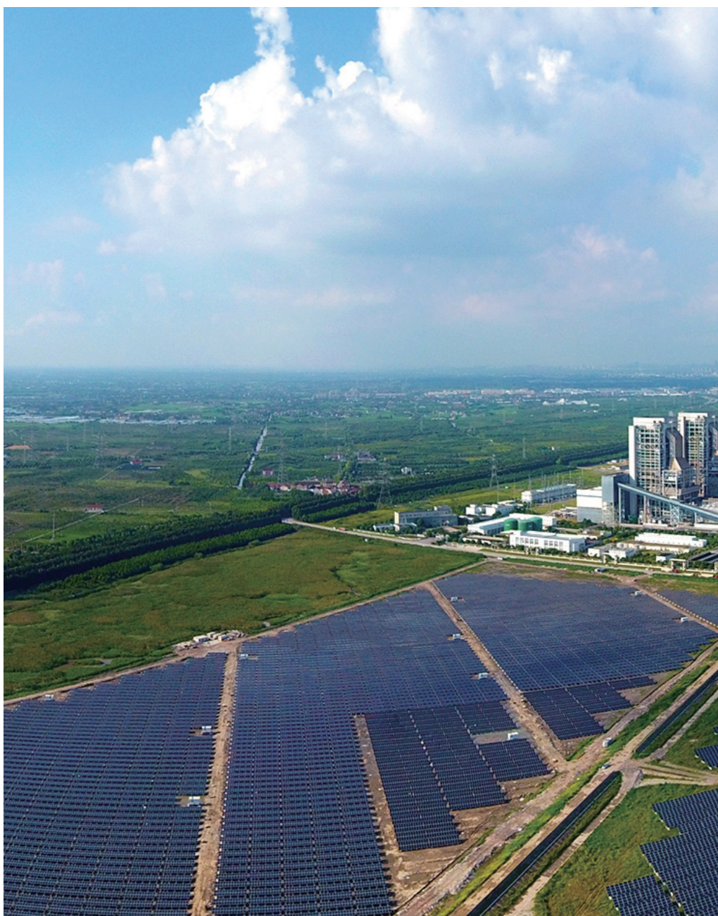
漕泾电厂厂区周边可移动式光伏
