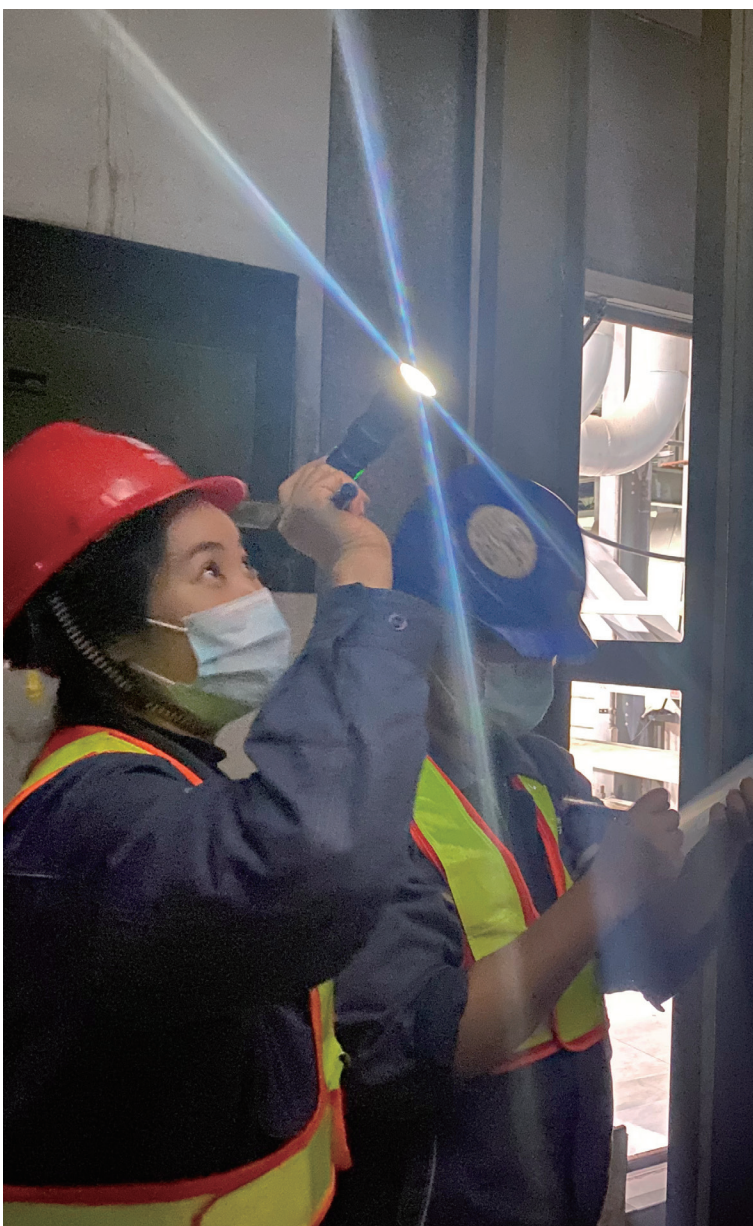
做好设备检修，保障电力可靠供应
