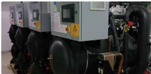
上实服务更换上实大厦3#冷水机组，采用磁悬浮技术代替传统螺杆式制冷，从而实现节约电能和维护成本。
