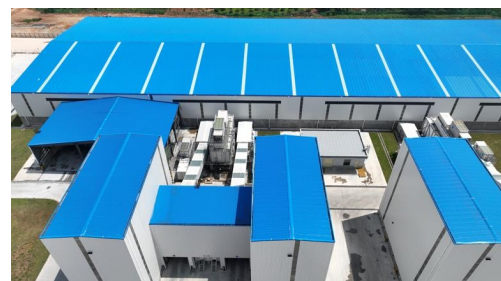
生产环节全封闭式搅拌站，实现精细治扬尘
