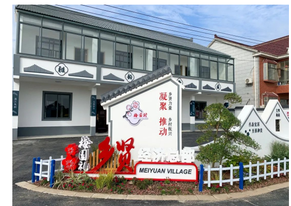
上海市奉贤区金汇镇梅园村基础设施修建现状
