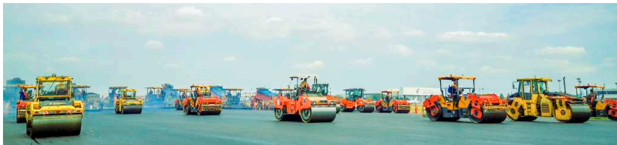
虹桥机场沥青加铺
