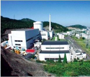
中核集团秦山核电站一期 CNNC Qinshan NPP Phase 1
