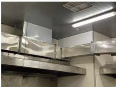
更新排烟管道
