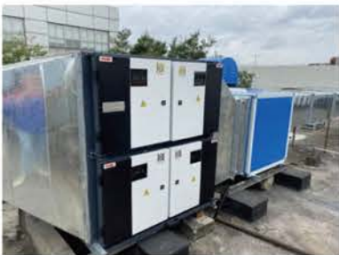
更新净化设施及风机
