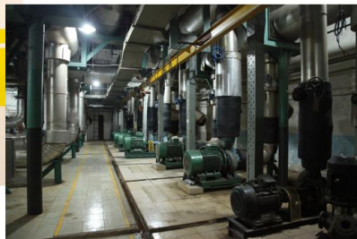
原水泵1995年生产，老旧故障多；大小泵同时使用，循环效果不佳。
