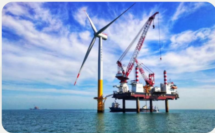
上海电气集团福建海上风电制造基地建设项目 服务类型：全过程工程造价咨询
