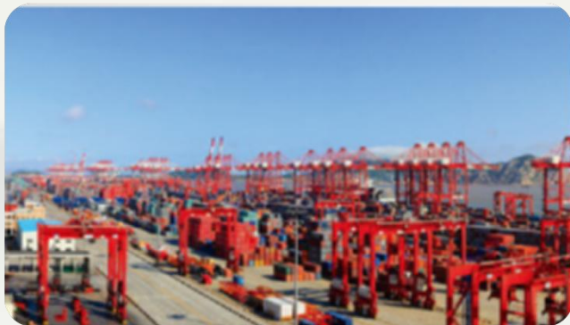
项目名称： 上海国际航运中心洋山深水港码头工程 (上海市重大建设项目) 服务类型： 全过程造价控制
