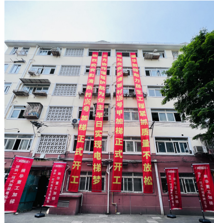
公司电梯加装项目正式开工
