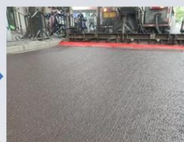
摊铺稀浆混合料
