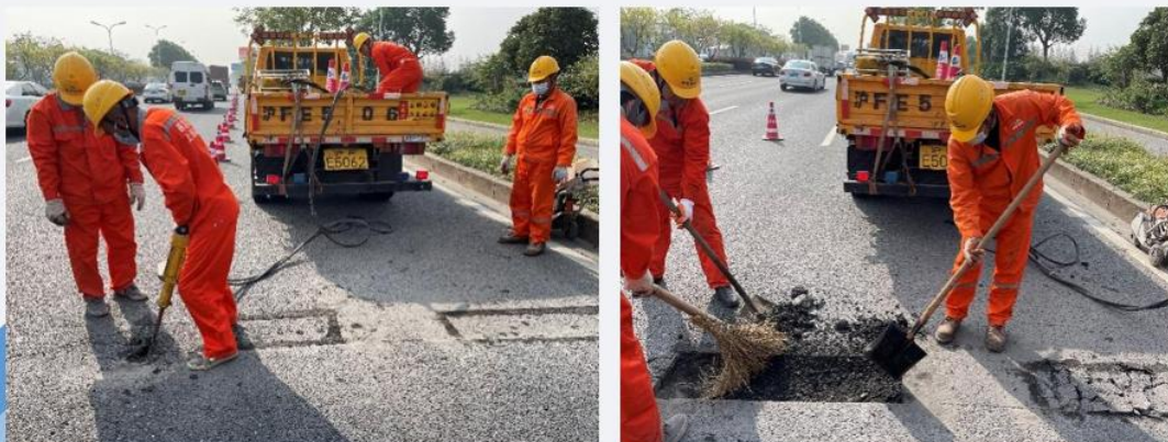
坑槽施工缝修复
