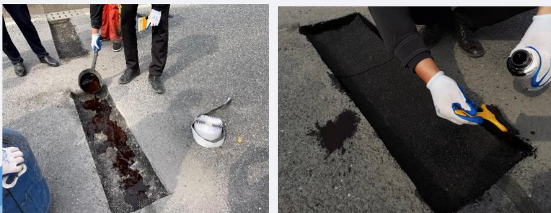
坑槽施工缝修复
