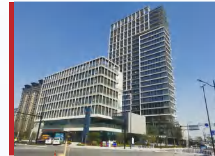
南浔塘南岸新建工程-西区块EPC总承包项目
