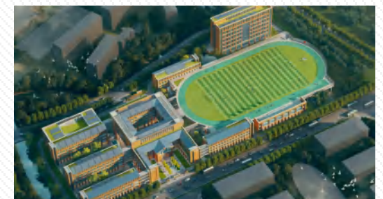
五建承建华师大二附中普陀校区新建工程
