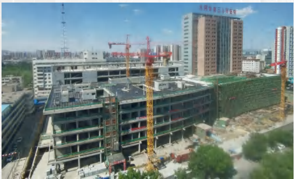
大同市第三人民医院新建医技楼项目全面封顶
