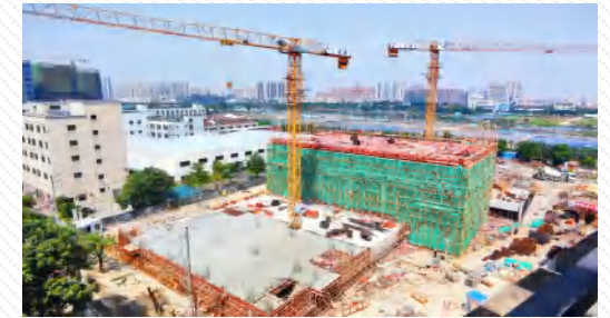
五建承建中山市西区产业创新平台基础设施及智慧城市建设项目
