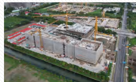
上海市实验学校嘉定新城分校新建工程实现结构封顶
