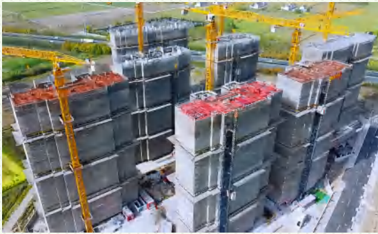
亭林新社区10-01地块动迁安置房项目实现结构封顶
