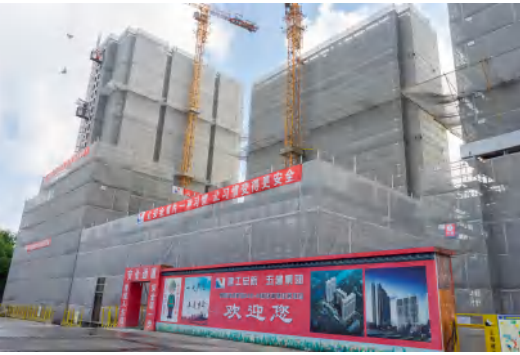
嘉定新成社区A03-06地块租赁住房项目结构封顶
