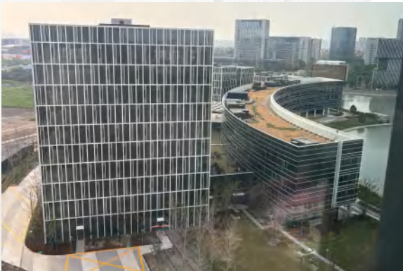
SMG全媒体创新平台（东方智媒城C-02B-01地块项目） 竣工验收
