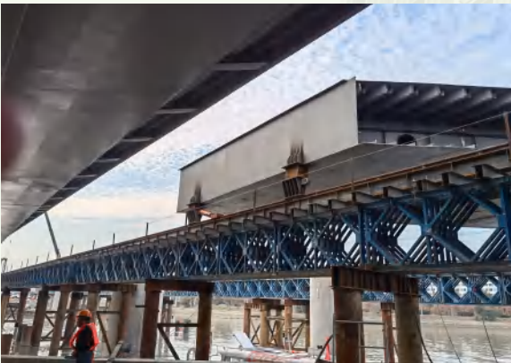
叶新-大叶公路（新工路-老黄桥港）道路二标项目 顺利完成茹塘大桥落梁施工
