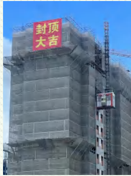
新场镇16号线核心区征收安置房项目首栋单体结构封顶
