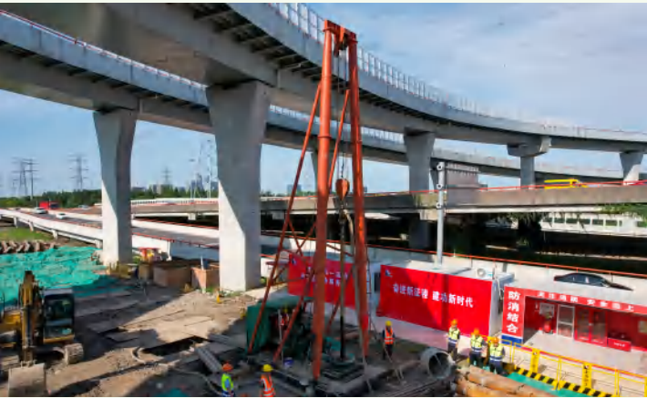
外环东段（华夏中路-龙东大道）交通功能提升工程打下第一桩
