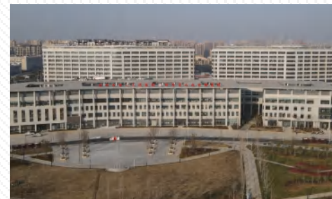
蚌埠市第二人民医院新院区项目顺利通过竣工验收
