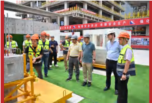
御桥10A-02地块项目举行2023年上海市建设工程安全生产月综合创优观摩工地
