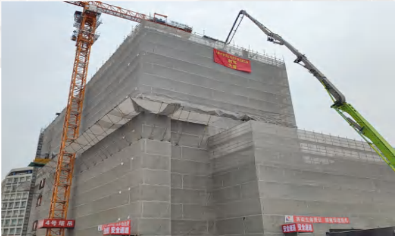
上海大学宝山校区扩建四期项目所有单体实现结构封顶
