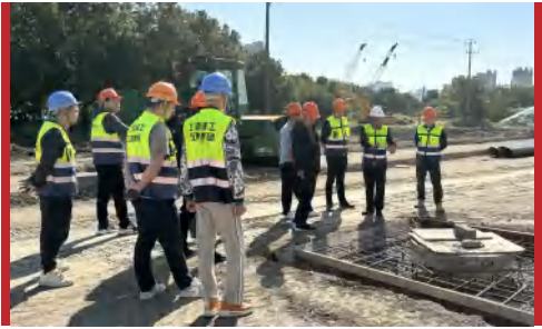
五建安全生产督察队赴徐泾镇双联路道路新建工程开展安全排查整治专项工作
