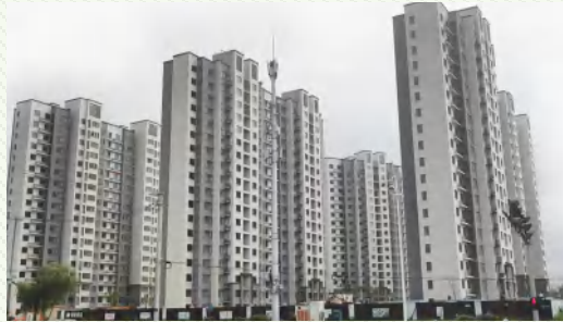
菊园社区42-06地块动迁安置房项目通过竣工验收
