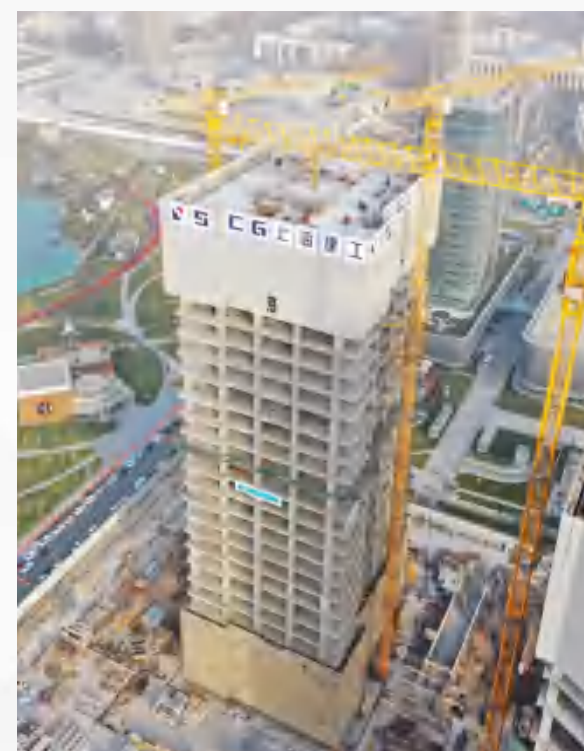
五建集团ECP项目 乌兹别克斯坦三座银行办公总部全面封顶
