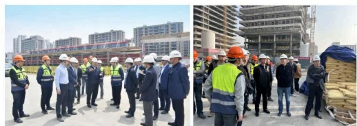
△ 工地安全检查
