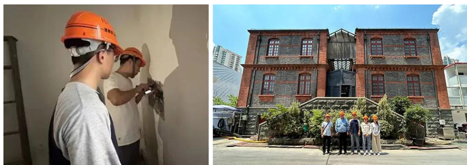
图 16 更新评估咨询中心团队在优秀历史建筑质量综合检测工作现场
