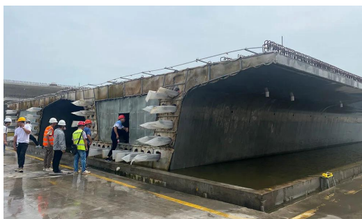
图 20 巢马铁路项目团队在新建巢湖至马鞍山城际铁路项目现场
