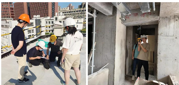
图 19 低碳检测认证团队在集团科研办公楼改和自贸区临港新片区项目现场
