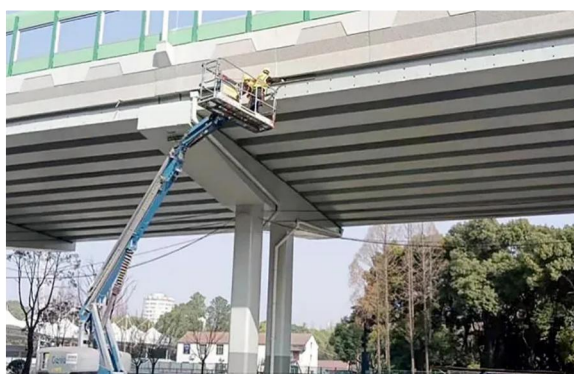
图 11 桥梁健康监测设备安装
