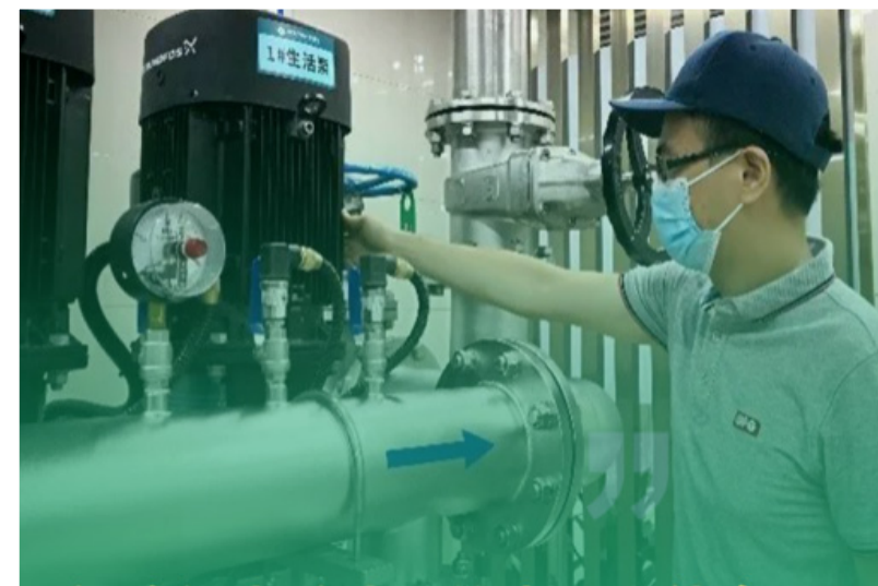
威派格响应了深圳小区物业需求派人紧急维修，恢复小区供水
