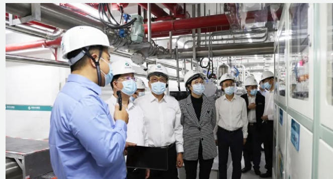
2022 年 4 月，人大常委会主任率部分市人大代表与深圳水务集团等单位代表 30 余人现场调研威派格参与建设的深云村二次供水设施改造项目。
