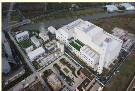
区再生能源综合利用中心项目完工
