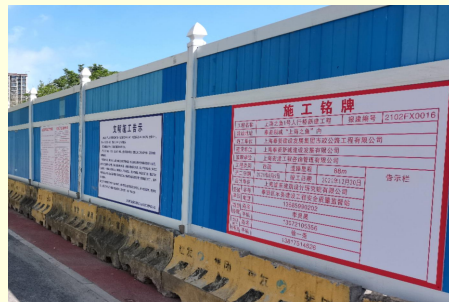
施工区域挂牌施工
