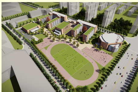
金汇九年一贯制学校项目开工
