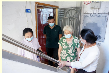
圆梦安装楼梯扶手
