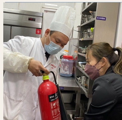
灭火器效期检查
