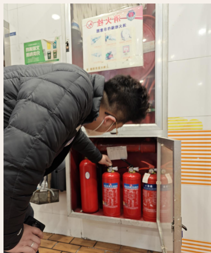
消防安全巡察
