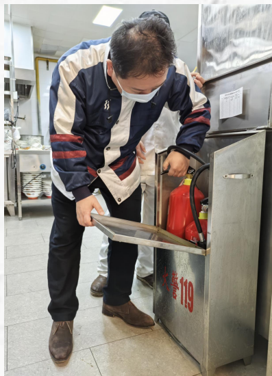
消防安全巡察
