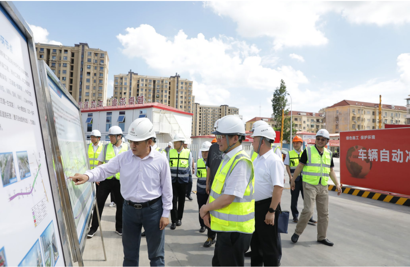
在漕宝路快速路新建工程 3 标外环工作井现场开展安全检查
