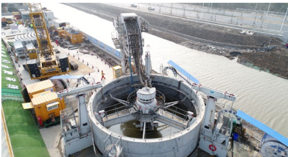
国内首例采用 VSM 工艺竖井（SAM 工法）作为顶管始发及接收井
