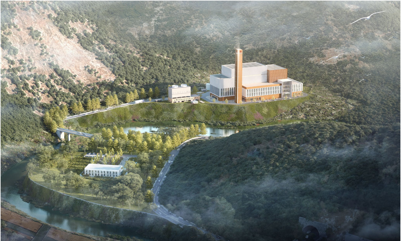
陇南垃圾焚烧厂
