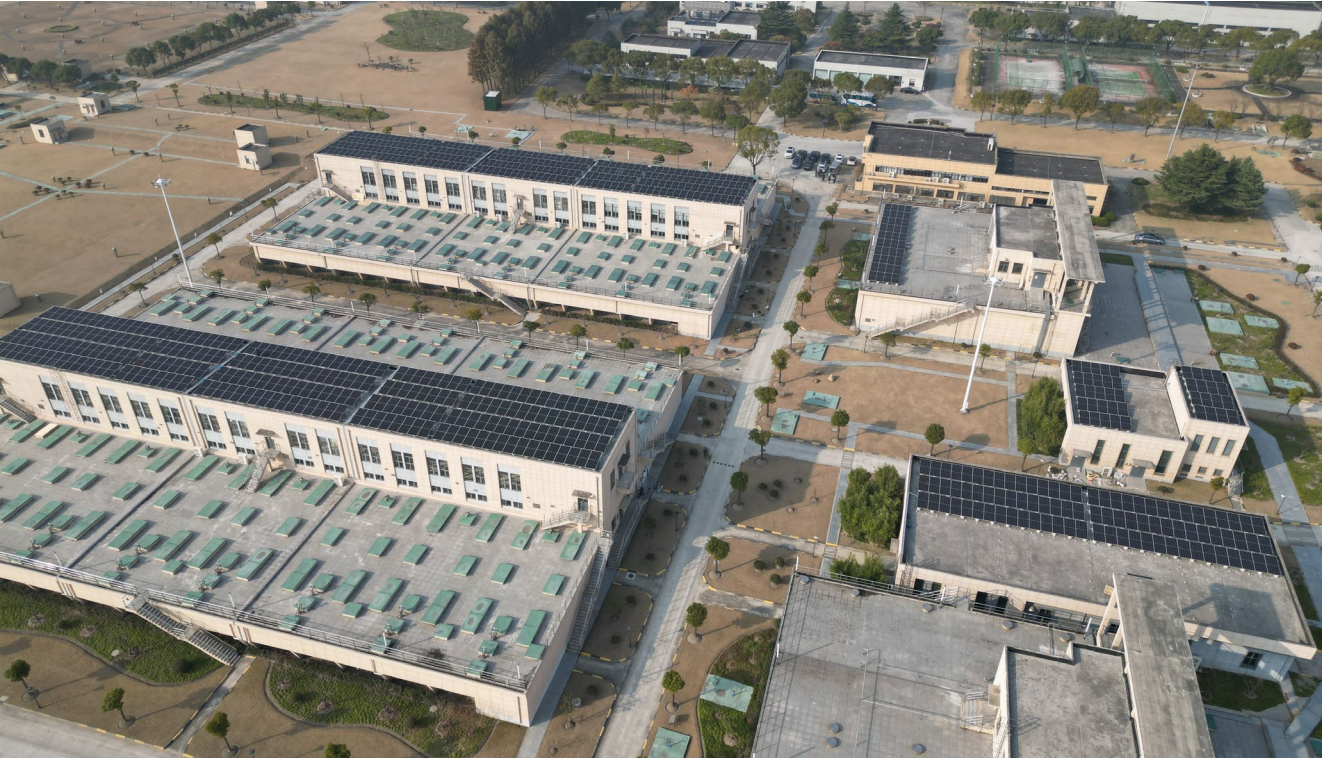
泰和水厂光伏发电项目顺利并网
