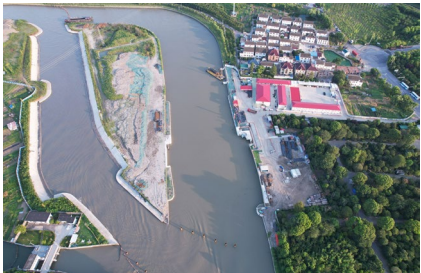
吴淞江工程（上海段）苏州河西闸
