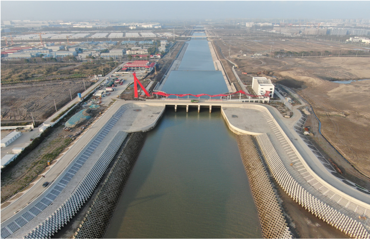
泐马河出海闸新建工程
