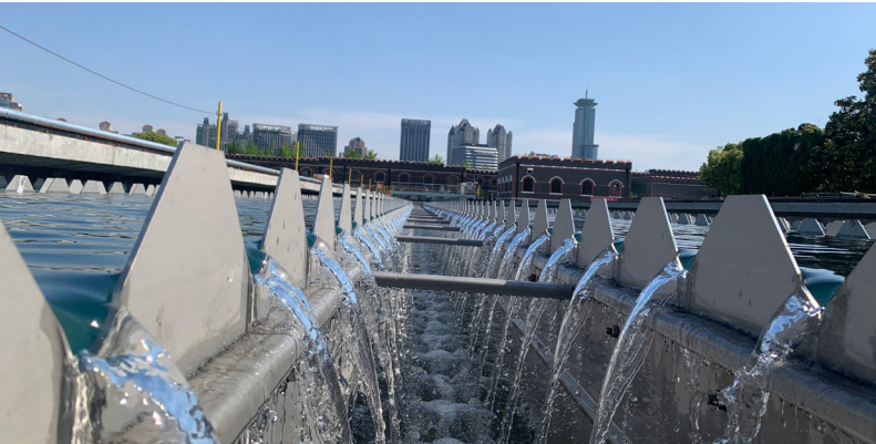
杨树浦水厂深度处理工程一阶段常规处理系统并网通水
