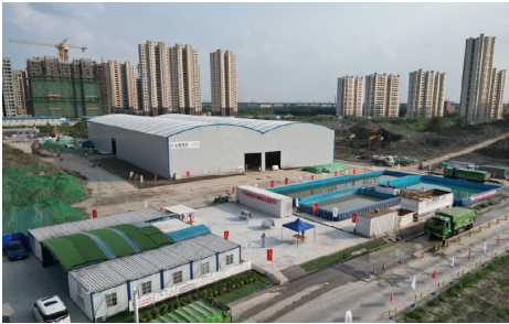
嘉定 02 地块土壤修复项目
