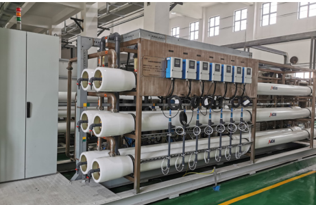
松江湿垃圾沼液和渗滤液协同处理项目单线 300td 的反渗透膜示范线
