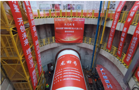
龙华污水处理厂初雨调蓄工程
