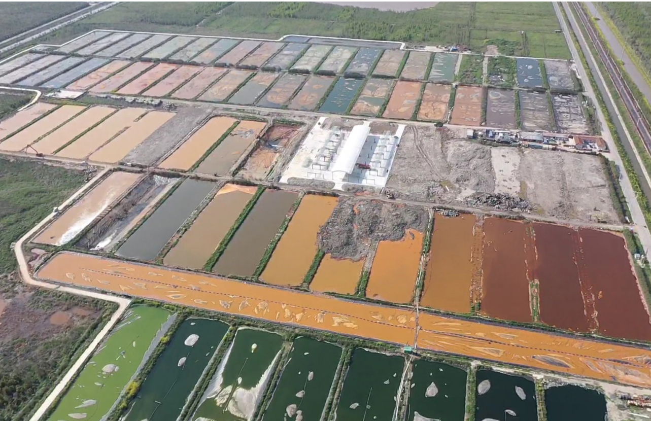
老港基地污泥库处理处置工程
