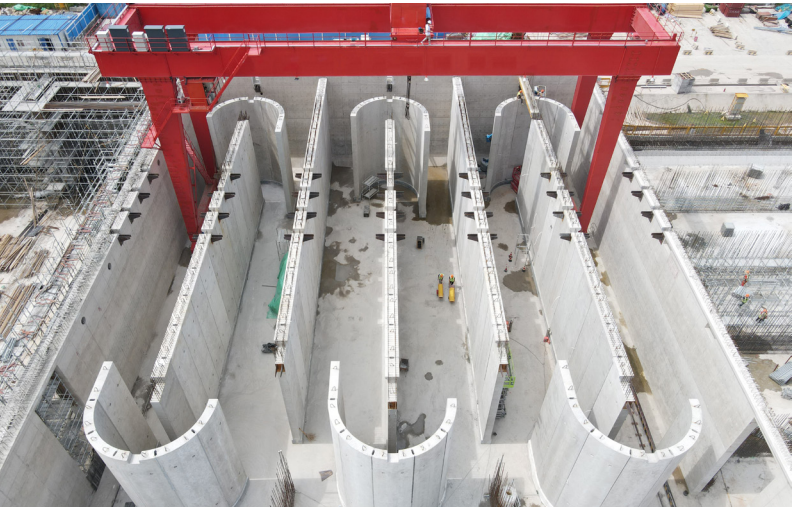
竹园污水处理厂四期工程
