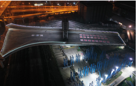
漕宝路快速路新建工程实现国内首座超宽三维不对称转体桥成功转体
