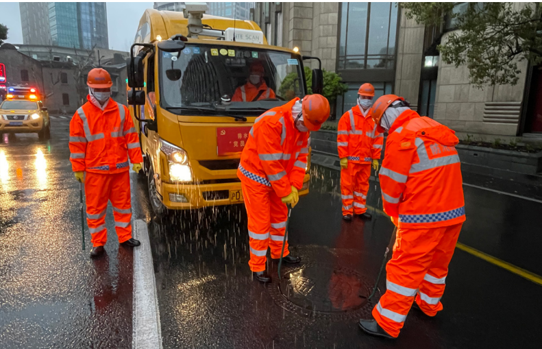
排水应急救援队开展防汛排水巡视任务
