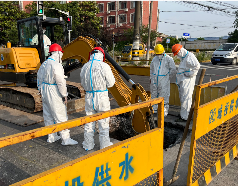
老旧管网改造
