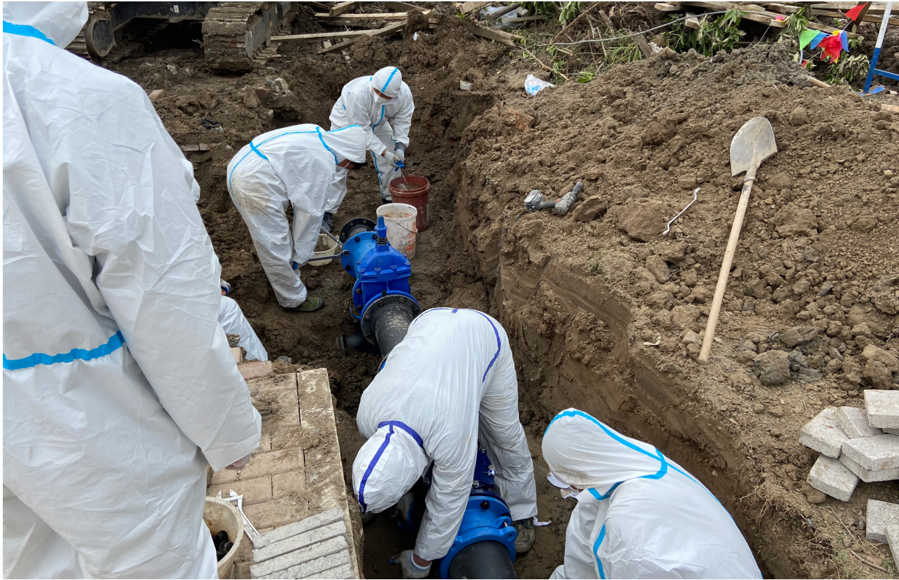
帮助临港方舱接通供水
