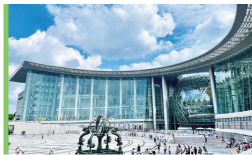
▲数字赋能科创科普，旗下仪电鑫森为上海科技馆承建集群化智慧管理大系统项目
