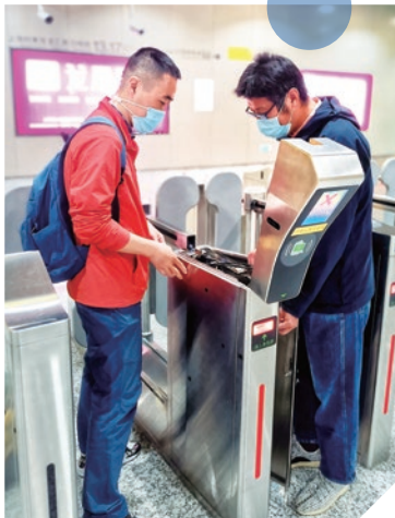
▲ 仪电物联智能交通事业部采用三班轮转制，对进博会场馆附近的地铁站AFC系统等进行全面巡检
