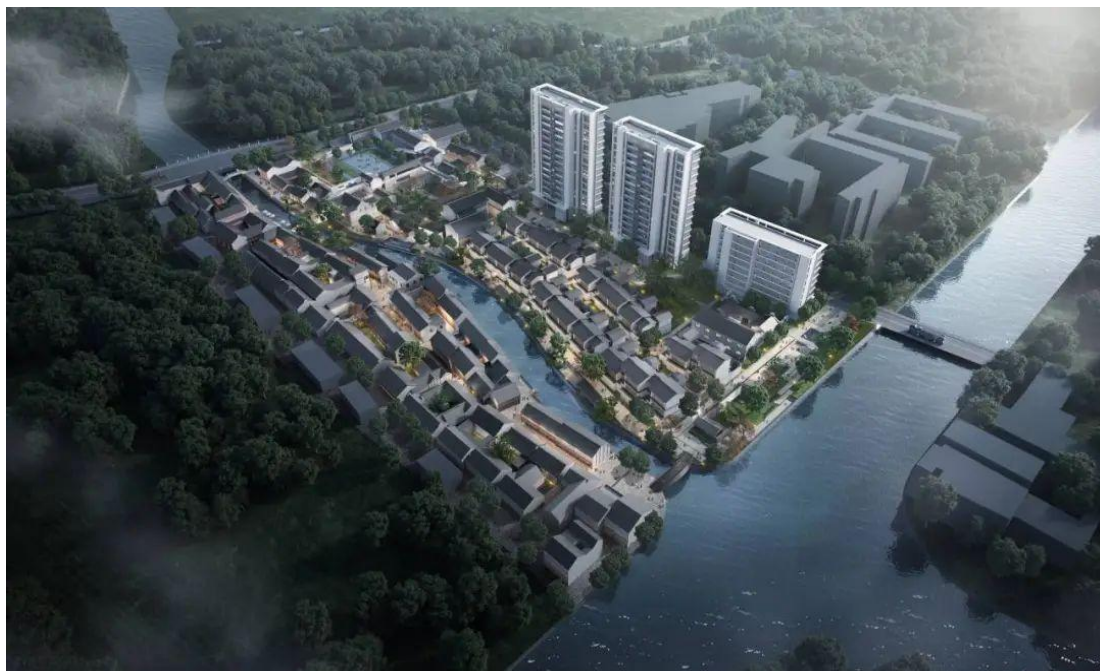
上海市浦东新区张江城中村改造项目建筑面积约 56 万平方米
