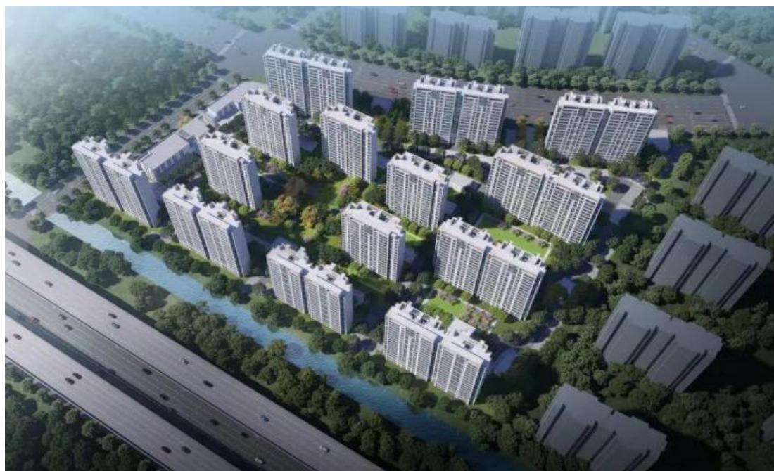
上海市浦东新区松江南站安置房项目建筑面积约 17 万平方米
