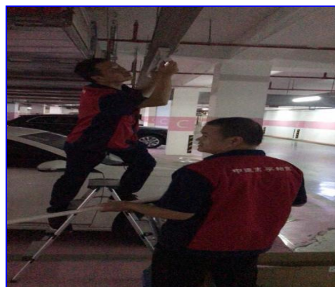
更换智能雷达感应灯具（LED-T8-3/15W 灯管）
