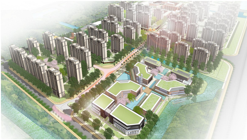
上海市浦东新区曹路区级安置房项目建筑面积约 148 万平方米
